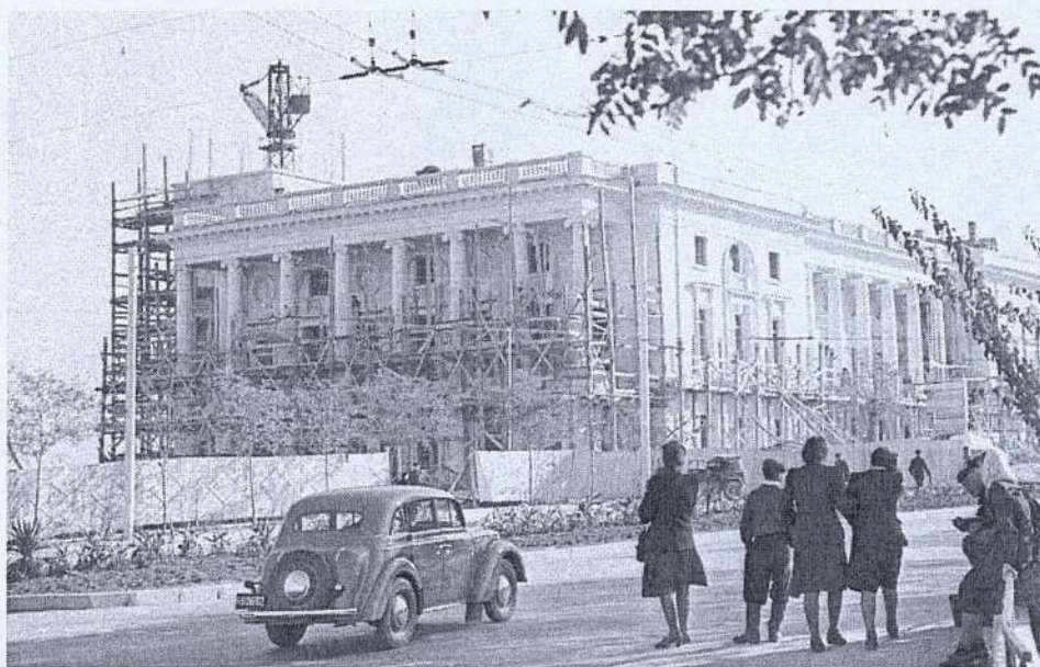
Строительство Матросского клуба. 1-я пол.1950-х гг. Фото Покатило М.Б.
