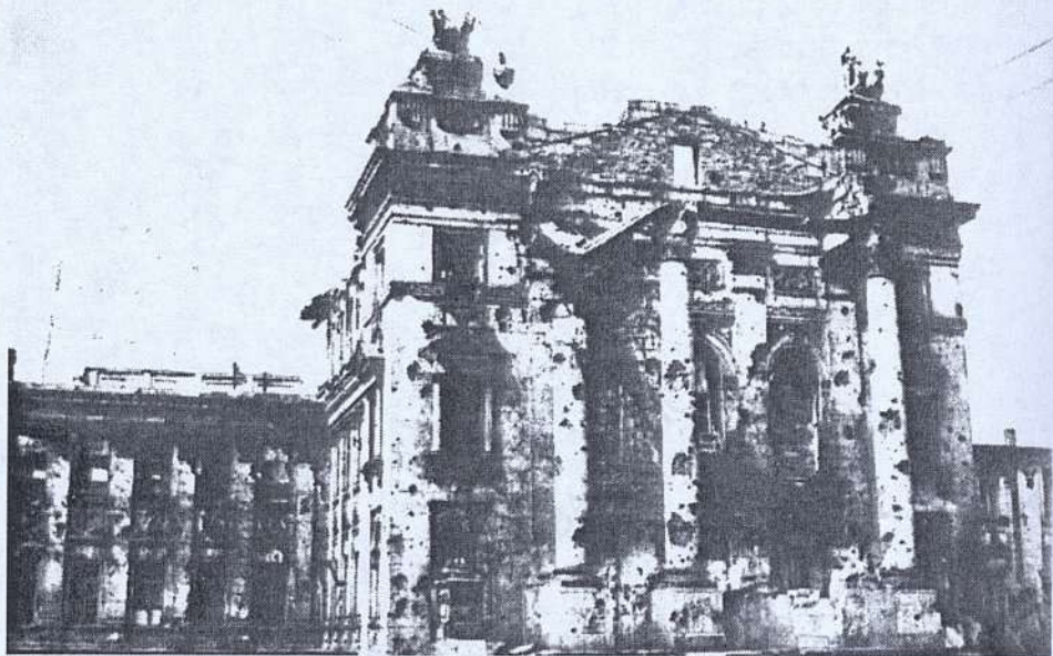
Разрушенное здание Института физических методов лечения им. Сеченова. 1941-1942 гг.
