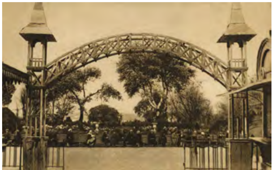
Севастополь. Вход на Приморский бульвар. Издание Контрагентства печати. Москва, 1920-е гг. Открытка из собрания А.В. Дербасова
